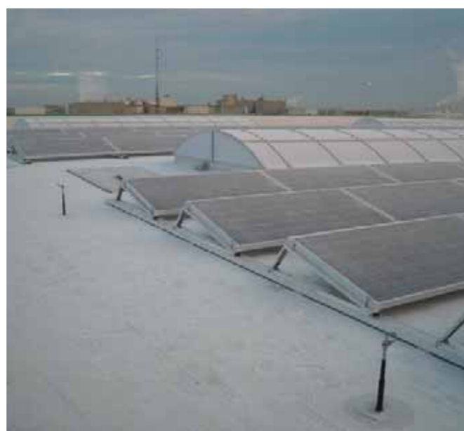
Installation de panneaux photovoltaïques sur les entrepôts de DP World Breakbulk à Anvers, financée par Dexia dans le cadre de son offre Dexia Energy Line – Énergie renouvelable
